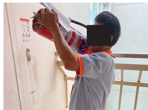
การตรวจสอบอุปกรณ์ในระบบป้องกันอัคคีภัย
